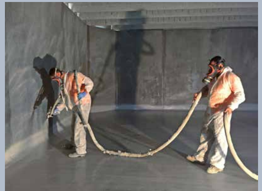
Impermeabilització per pulverització d'un dipòsit d'aigua potable d'obra civil.
